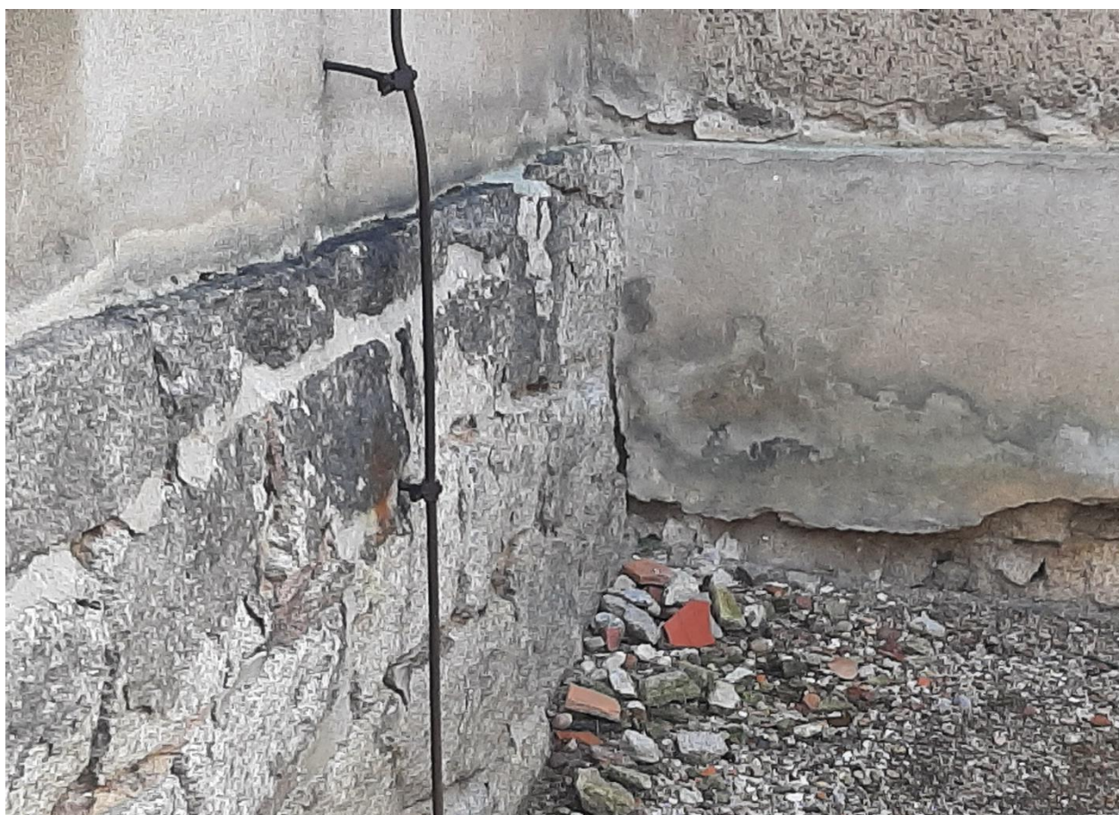
Fot. 30 .Kościół Parafialny w Maniowie Wielkim. Fragmenty połączenia elewacji bocznej południowej wieży ze ścianą zachodnią korpusu nawy . Na tej samej wysokości oraz stopniu wysunięcia znajduje się obszar cokołu tynkowanego oraz cokołu pozbawionego tynku . Fugi w obrębie pasa granitu zerodowane - odpajają się i wykruszają .
