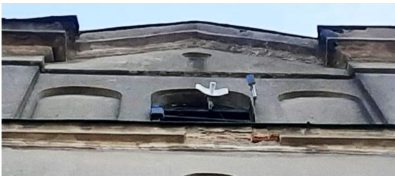
Fot. 27 i 28 .Kościół Parafialny w Maniowie Wielkim. Fragmenty elewacji frontowej , zachodniej wieży w partii szczytowej ; czytelne poważne zniszczenia odcinkowe i powierzchniowe w ciągach gzymsów .
