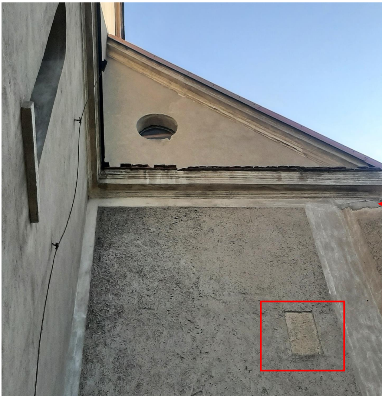
Fot.1. Kościół Parafialny w Maniowie Wielkim . Lokalizacja „świadka” na ścianie zachodniej w części południowej korpusu . Czytelne silne zabrudzenie fakturalnej powierzchni , wypłukanie białej malatury na powierzchni obramień , spetryfikowane czarne zacieki w obrębie gzymsu. Pod gzymsem pas cementowego kitu naprawczego .
