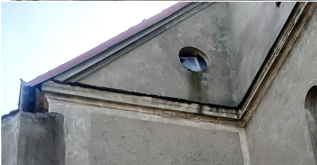
Fot. 21 i 22. Kościół Parafialny w Maniowie Wielkim. Fragmenty styku elewacji północnej korpusu nawy w kierunku wschodnim ze ścianą zachodnią prezbiterium. Widoczne ubytki w obrębie gzymsu. Zabrudzenia powierzchni tynku podkreślają sposób jego nakładania
