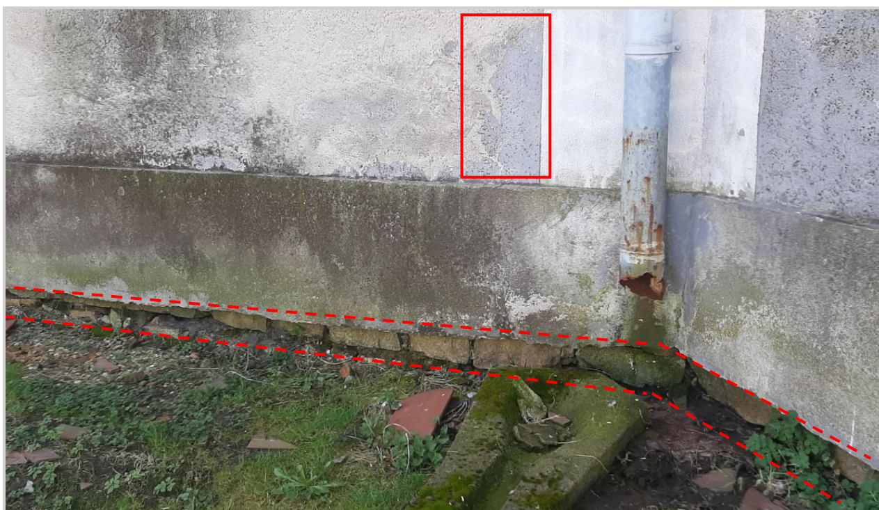
Fot. 7.. Kościół Parafialny w Maniowie Wielkim . Fragmenty pasa cokołowego korpusu nawy elewacji pn . Oznaczone miejsce po usunięciu cementowej wylewki odsłaniające ceglana konstrukcję muru . Wyraźne zniszczenia skumulowane na powierzchni tynku ( czarne osady , glony ) powstałe w wyniku zawilgocenia , cienkowarstwowe złuszczenia .
