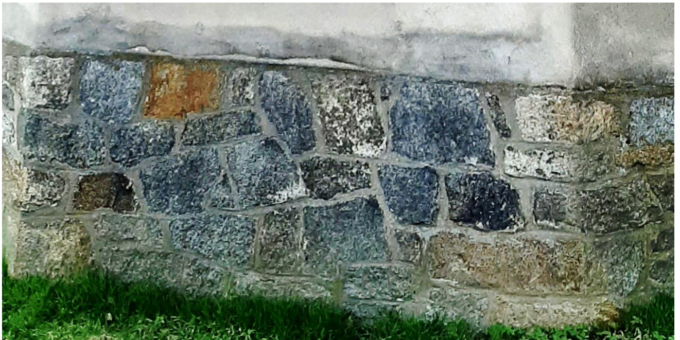
Fot. 31 i 32 .Kościół Parafialny w Maniowie Wielkim. Fragmenty elewacji bocznych kaplicy północnej z granitowym szerokim pasem cokołowym. Całość silnie zabrudzona ; czytelne zawilgocenie partii tynku ponad cokołem .
