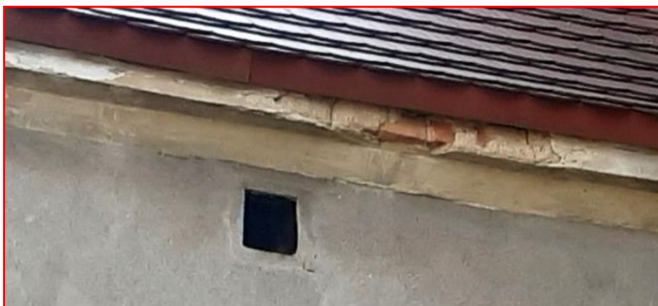
Fot.16 i 17. Kościół Parafialny w Maniowie Wielkim. Fragmenty ścian bocznych XIX-w kaplicy północnej z zaznaczonymi zniszczeniami w obrębie gzymsu wieńczącego.
