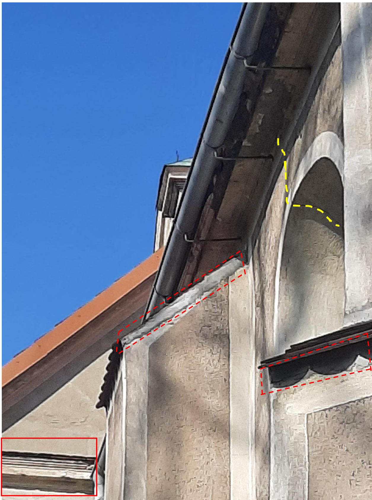
Fot. 20. Kościół Parafialny w Maniowie Wielkim. Fragmenty elewacji północnej korpusu nawy w kierunku wschodnim z widocznymi ubytkami w obrębie gzymsu oraz zaznaczone pęknięcia przechodzące z grubości muru na osi łuku otworu okiennego. Ponadto widoczne wykruszenia gzymsu na ścianie szczytowej prezbiterium oraz niestarannie wyprowadzone na lico muru zaprawy mocujące pod dachówkami.
