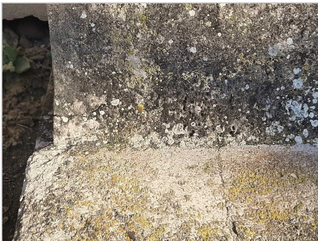
Fot. 4 i 5 . Kościół Parafialny w Maniowie Wielkim . Fragmenty przypór przy elewacji północnej . Czytelne spetryfikowane czarne osady oraz porośnięcie powierzchni przez mchy i porosty.
