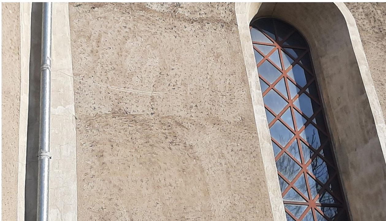
Fot. 2. Kościół Parafialny w Maniowie Wielkim . Fragmenty fakturalnego tynku na ścianie południowej korpusu nawowego.
