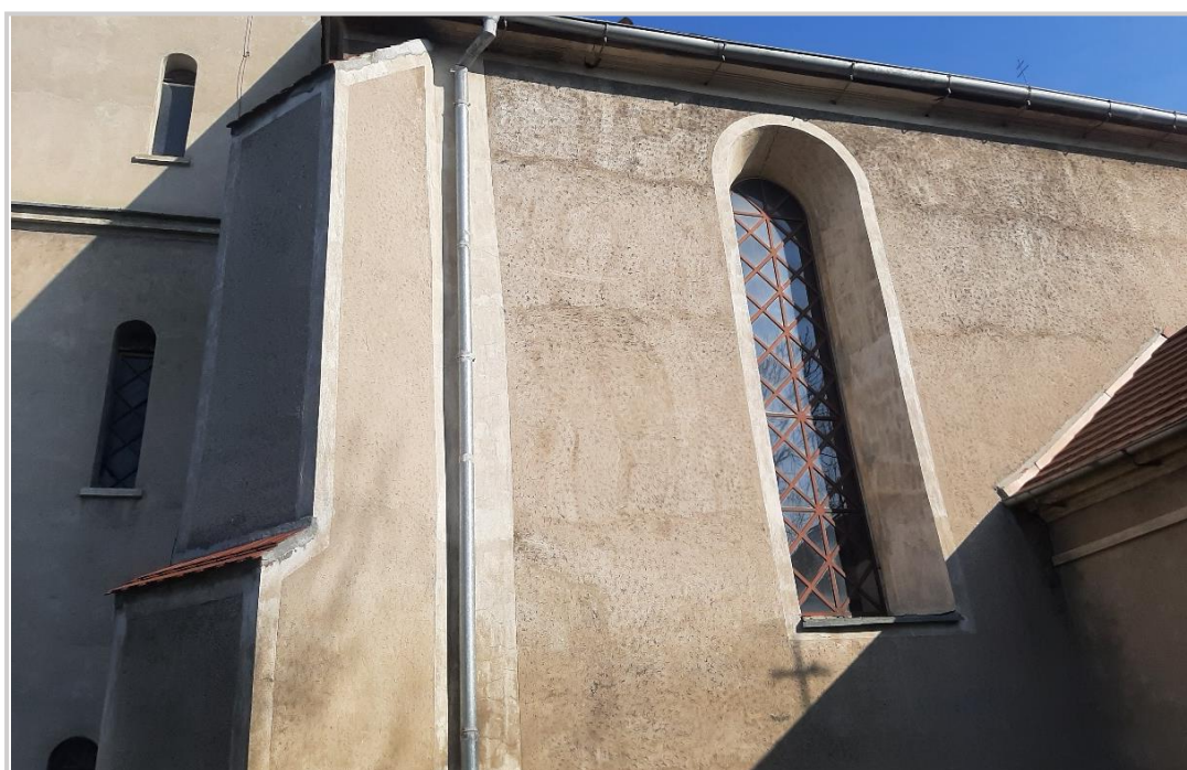
Fot. 5 i 6 . Kościół Parafialny w Maniowie Wielkim . Fragmenty elewacji pn i pd korpusu nawy z uwidocznionym prze zabrudzenie faktury systemem nakładania tynków.
