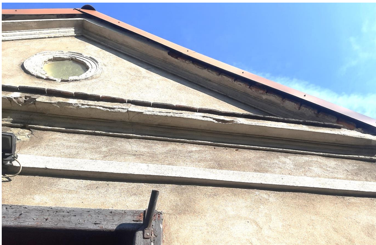
Fot. 25 i 26 .Kościół Parafialny w Maniowie Wielkim. Fragmenty elewacji frontowej kruchty południowej ; czytelne zniszczenia w ciągach gzymsów oraz obramieniu okulusa.
