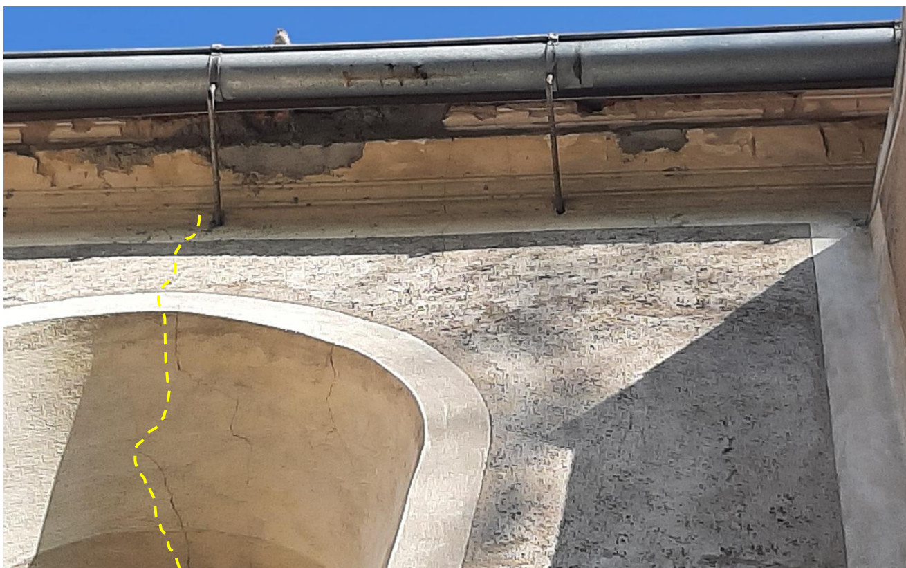
Fot. 18 i 19. Kościół Parafialny w Maniowie Wielkim. Fragmenty elewacji północnej korpusu nawy z widocznymi ubytkami w obrębie gzymsu oraz zaznaczone pęknięcia przechodzące z grubości muru na osi łuku otworu okiennego.
